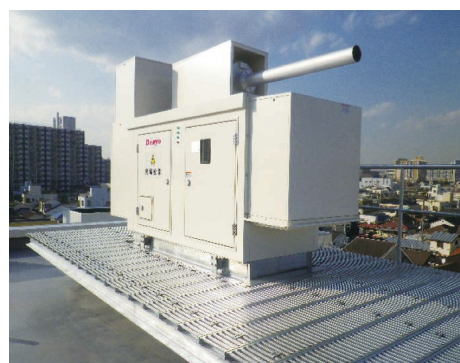
発電機更新工事
